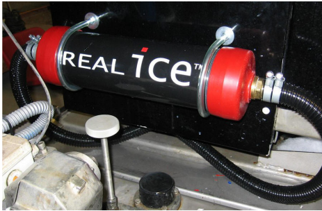
Lähikuva asennuksesta Eisbear jäähoidokoneeseen
